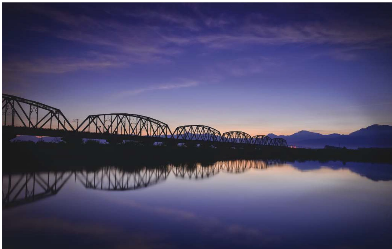
舊鐵橋上的日出。照片提供：李効儒（阿肯）
